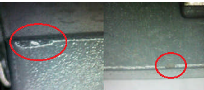
Abbildung 9: Eine Absplitterung im akzeptablen Maß am Berührungspunkt der Oberfläche
